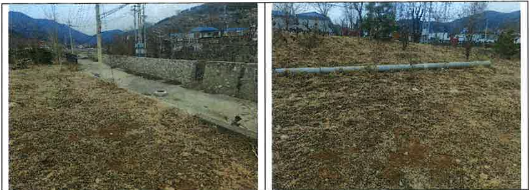
挡墙外侧表土剥离、表土回覆及土地整治恢复区域
