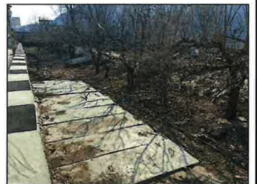
恢复暗涵破损盖板
