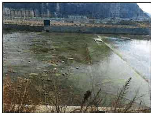
更换坝袋和闸门、重建管理房
