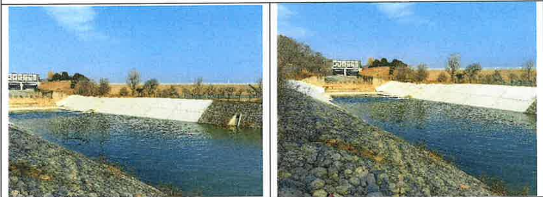
铅丝石笼护坡（本项目实施位置在水位以下）
