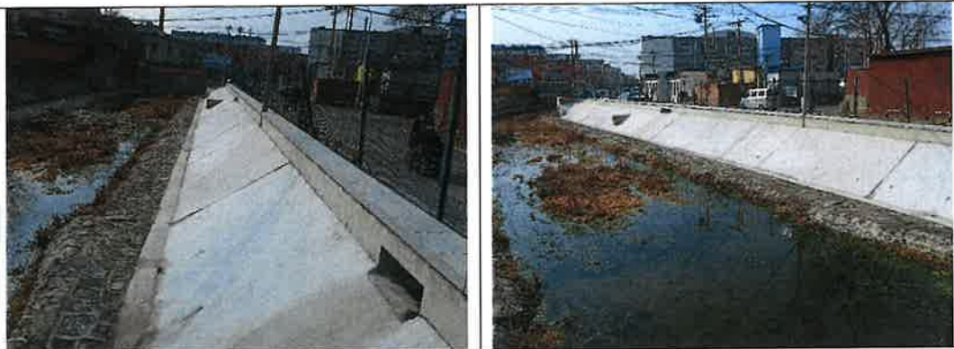
保健路桥下游右岸挡墙
