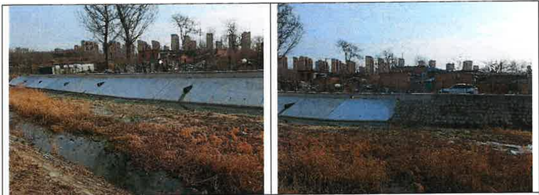
洪寺西桥上游左岸挡墙
