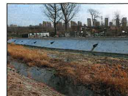
洪寺西桥上游左岸护坡
