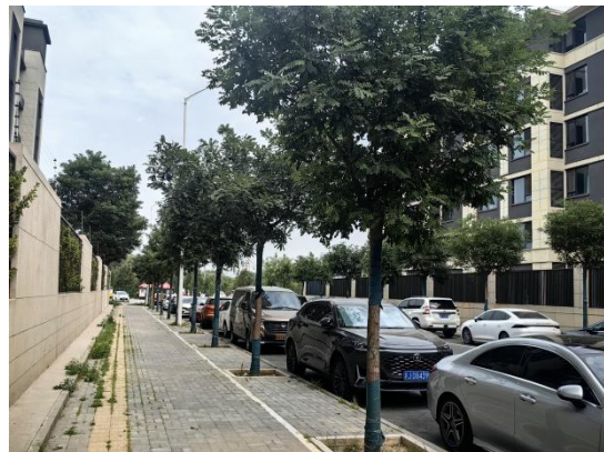
道路南侧透水砖铺装和树池绿化
