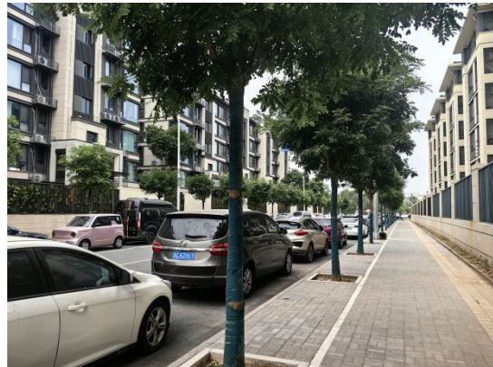
道路北侧透水砖铺装和树池绿化
