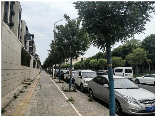
道路南侧透水砖铺装和树池绿化
