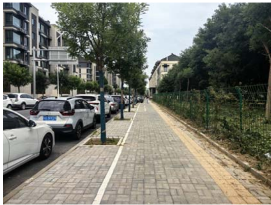
道路北侧透水砖铺装和树池绿化
