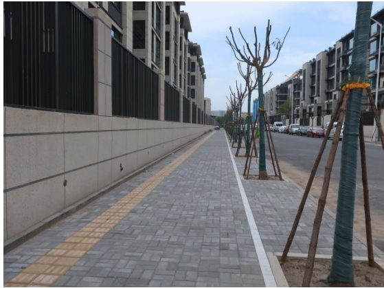
道路北侧道路终点至京西印月二期大门透水砖铺装-2023.7.6
