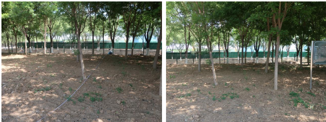
雨水口工程管线已基本施工完毕-2023.5.18
