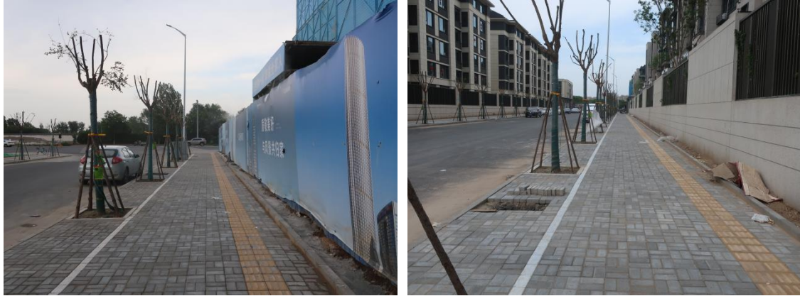
道路南侧透水砖铺装和行道树栽植-2023.7.6 人行道铺装和行道树栽植
