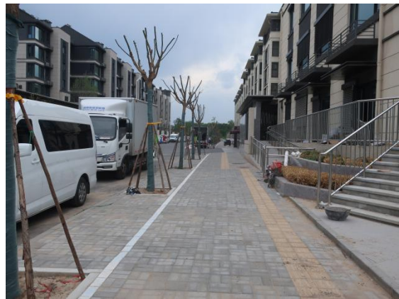
道路北侧京西印月二期大门~终点透水砖铺装、行道树栽植-2023.7.6
