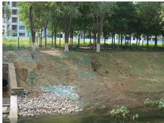
雨水口工程管线末端出水口护坡损坏-2023.9
