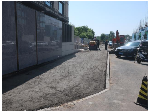
道路北侧京西印月二期大门~终点透水砖基层铺装-2023.5.18
