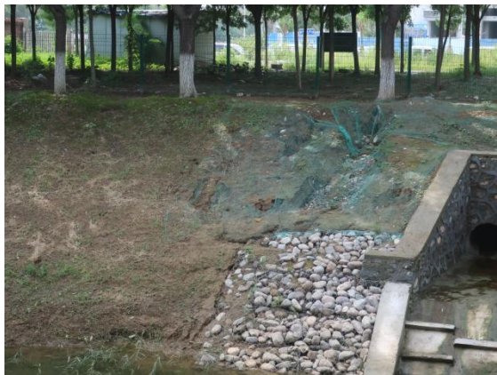
雨水口工程管线末端出水口护坡损坏-2023.9
