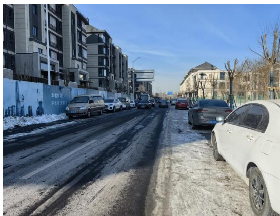
道路中部沥青路面-2023.12
