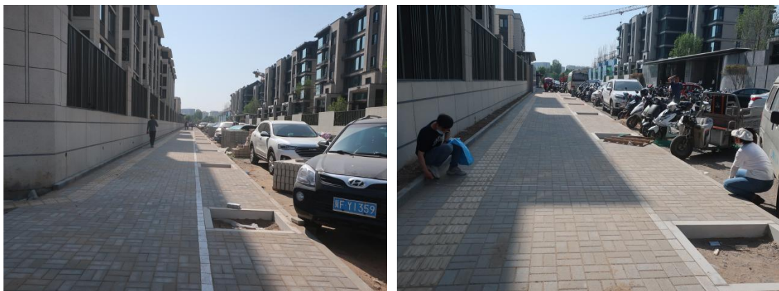
道路北侧道路终点至京西印月二期大门透水砖铺装-2023.5.18
