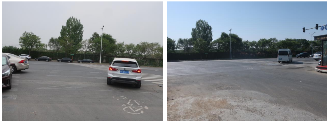
道路终点与现状阳光北大街交叉处-2023.4
