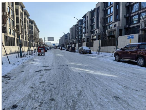
道路起点沥青路面-2023.12
