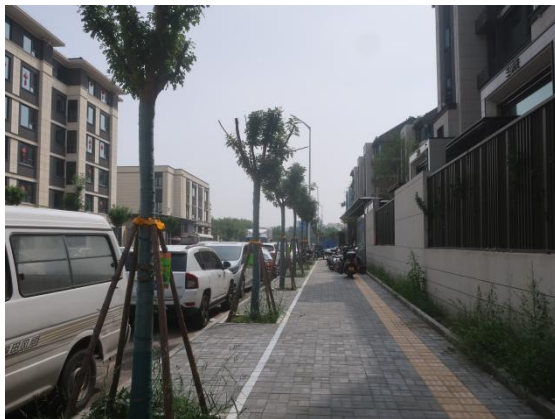
道路中部南侧透水砖铺装-2023.9
