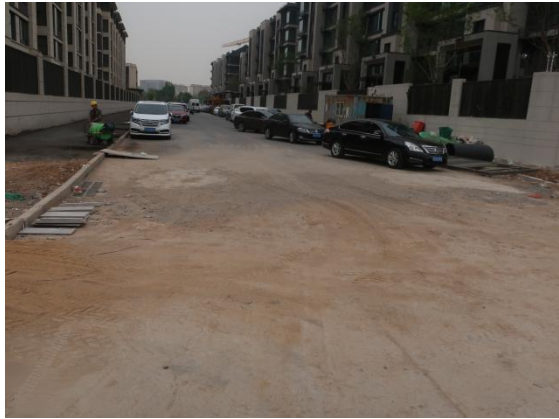
道路起点已完工沥青路面
