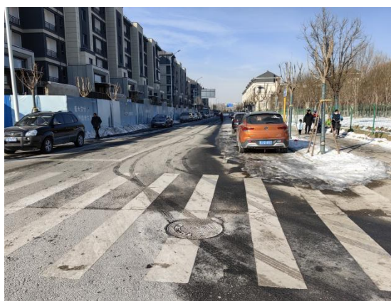
道路终点处沥青路面-2023.12
