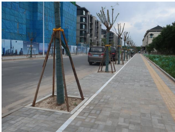
道路北侧京西印月二期大门~终点透水砖铺装、行道树栽植-2023.7.6
