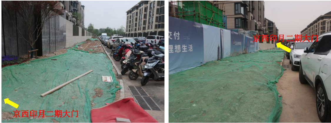
道路南侧京西印月大门西侧 20m 及南侧人行步道裸露地面临时覆盖-2023.4
