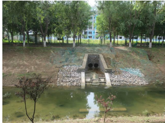
雨水口工程管线末端现状-2023.9
