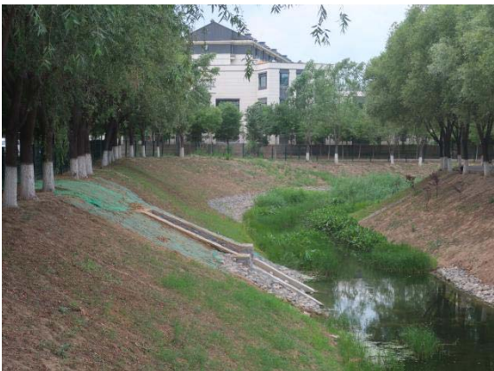
雨水口工程管线末端出水口和消力池施工完毕-2023.7.6
