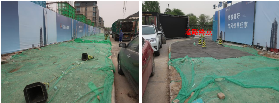
道路南侧道路终点至京西印月二期大门裸露地面临时覆盖 道路南侧人行道情况-2023.4
