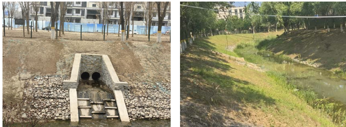
入河口护坡修复
