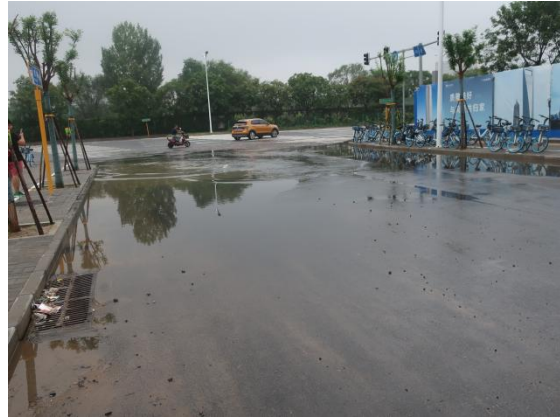
道路施工桩号终点 K0+324.46 处积水、泥沙-2023.8
