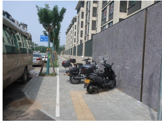
道路中部北侧透水砖铺装-2023.9
