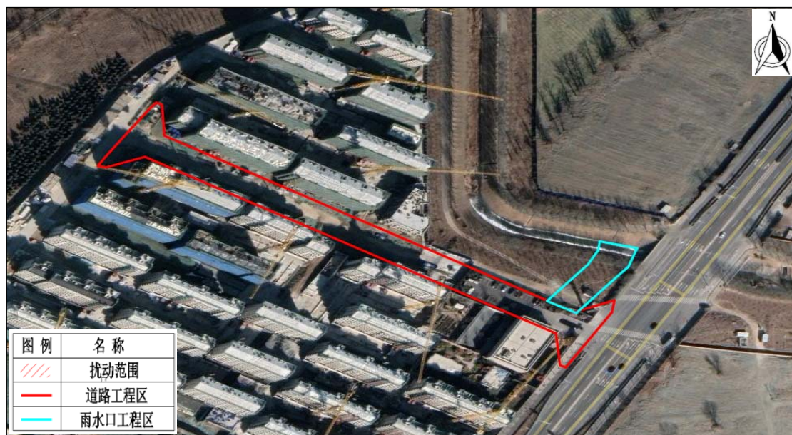
施工前遥感影像-2023.3
