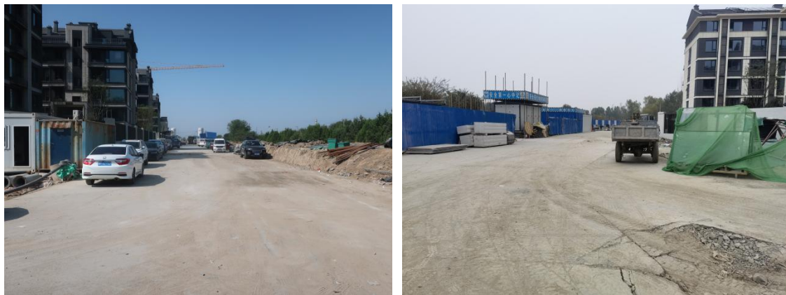
道路起点与规划黄良铁路交叉处-2023.4
