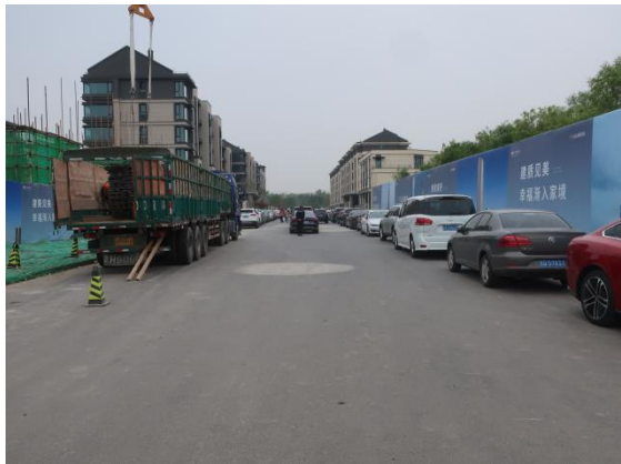
道路终点处已完工沥青路面
