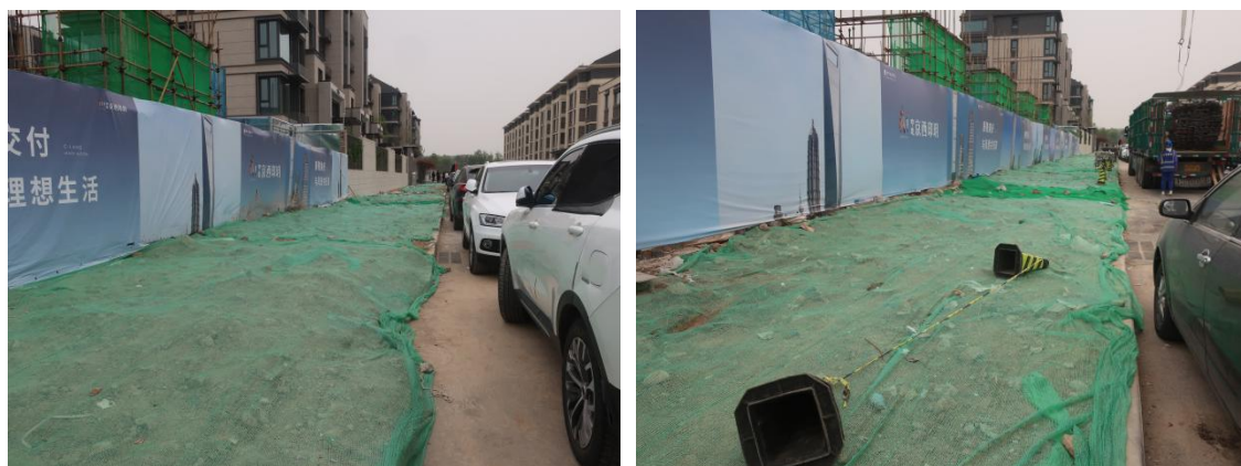
道路工程区临时覆盖
