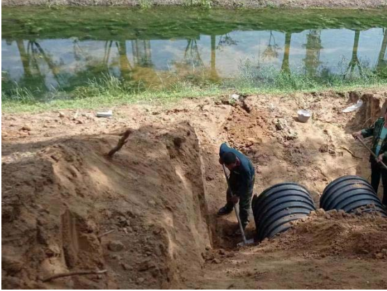
雨水口工程管线末端出水口和消力池施工-2023.6
