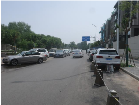
道路中部沥青路面铺装-2023.9
