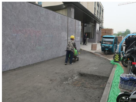
道路北侧起点至京西印月一期大门段透水砖人行道底层施工-2023.4
