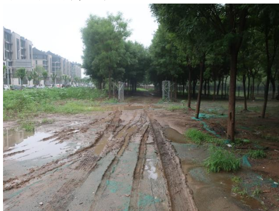
雨水口工程区部分临时覆盖被嵌入泥泞道路中、局部有积水-2023.8
