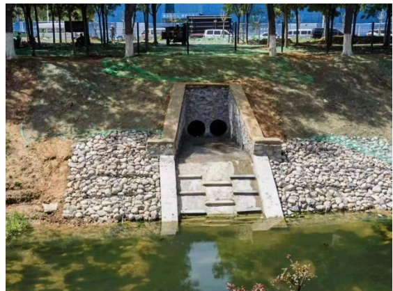
雨水口工程管线末端出水口和消力池施工完毕-2023.7.6
