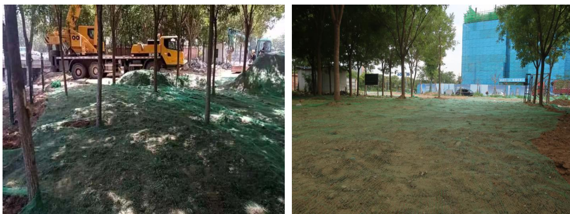
雨水口工程区临时覆盖
