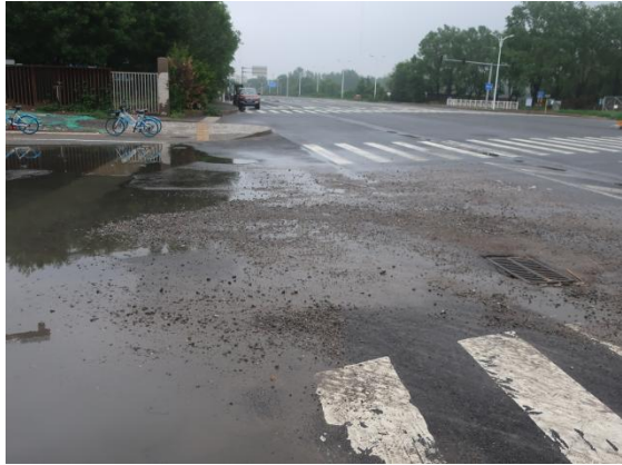
道路施工桩号终点 K0+324.46 处积水、泥沙-2023.8
