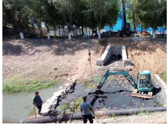
雨水口工程管线末端出水口和消力池施工-2023.6
