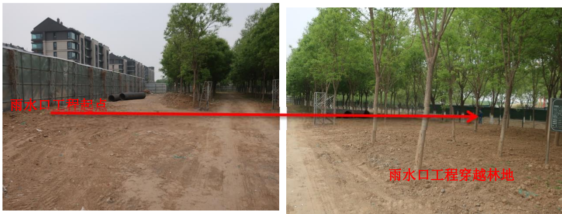
雨水口工程管线已基本施工完毕-2023.4.27
