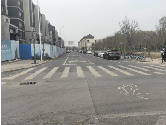
道路起点沥青路面-2024.4.2
