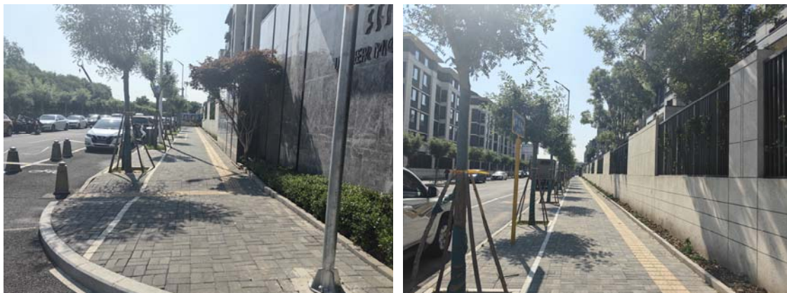
道路南侧透水砖铺装
