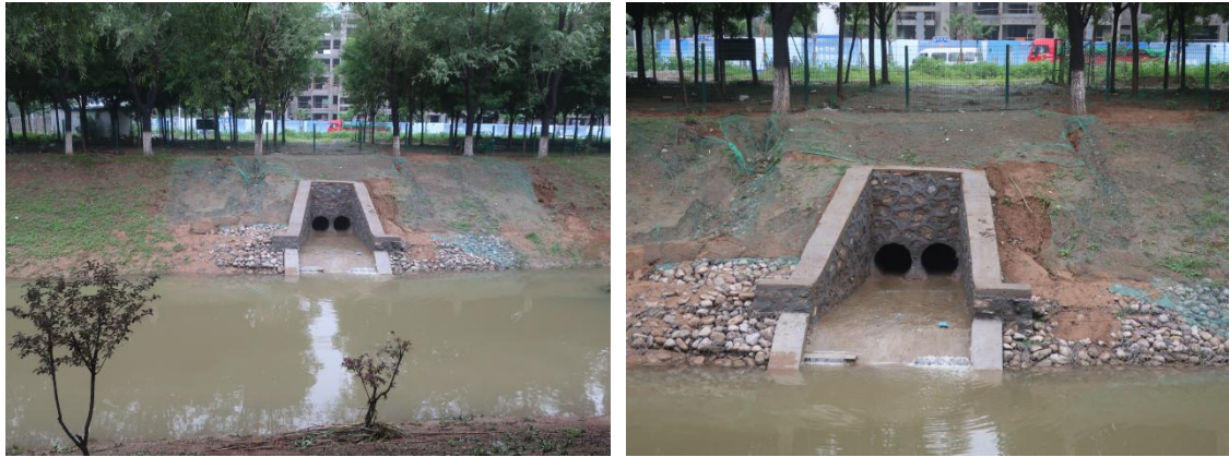
雨水口工程区管线末端出水口及其周边区域-2023.8
