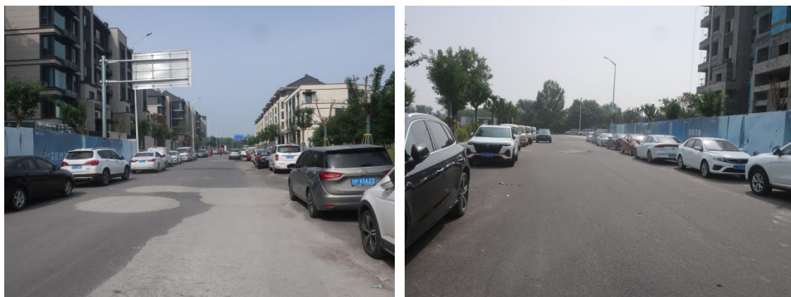
道路起点沥青路面-2023.9
