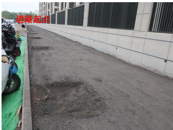
道路北侧起点至京西印月一期大门段透水砖人行道底层施工-2023.4
