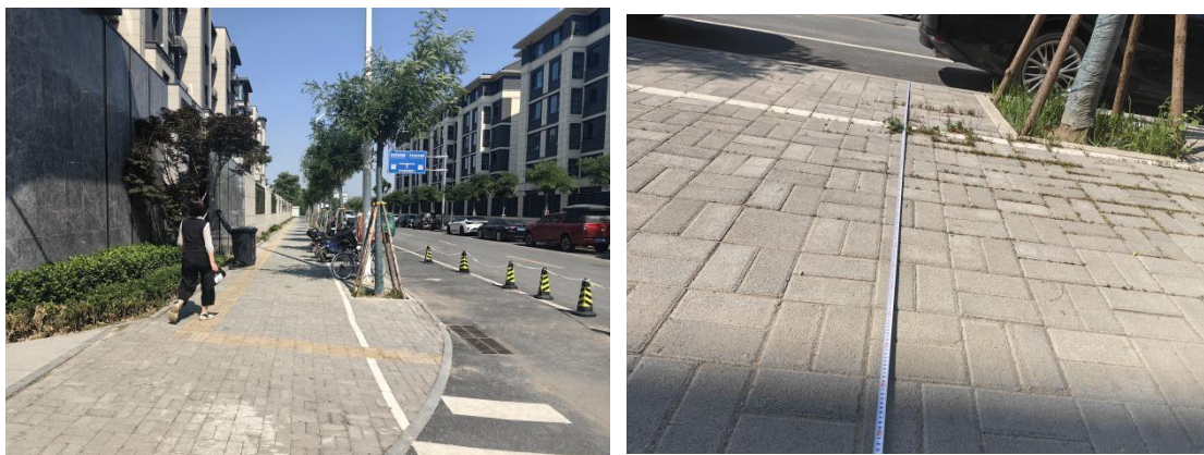
道路南侧透水砖铺装
