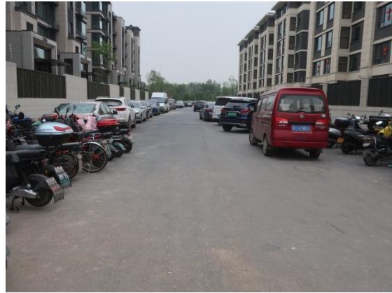
道路中部已完工沥青路面
